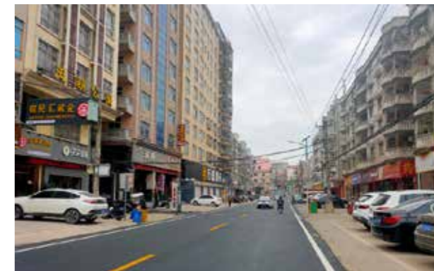
在东张村建设的“第六产业”生态小镇，配套建设300多家惠华商业街商铺
