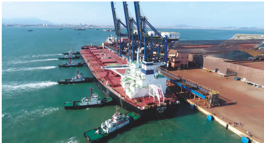
莆田罗屿港口为我国东南沿海最大矿石码头。图为莆田罗屿港口
