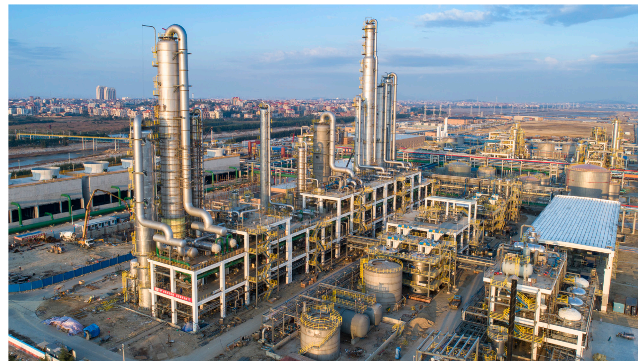
永荣科技厂区
