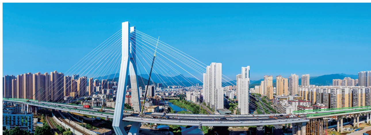
2020年10月30日，龙岩大桥竣工通车。该桥梁建设开创了世界钢箱梁斜拉桥二次转体施工先河
