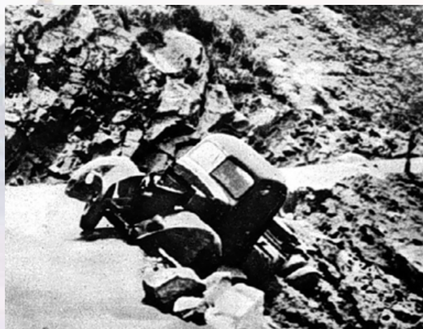
随时滑坡塌方
