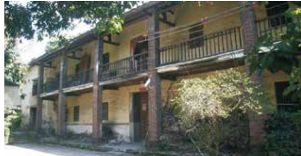
尤扬祖的故居金宝楼，修缮前
