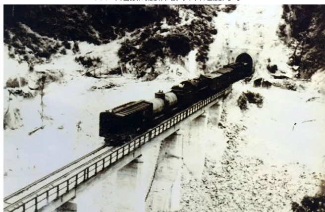
鹰厦铁路全线于1957年竣工通车。图为鹰厦铁路上的火车钻出闽北光泽县铁牛关
