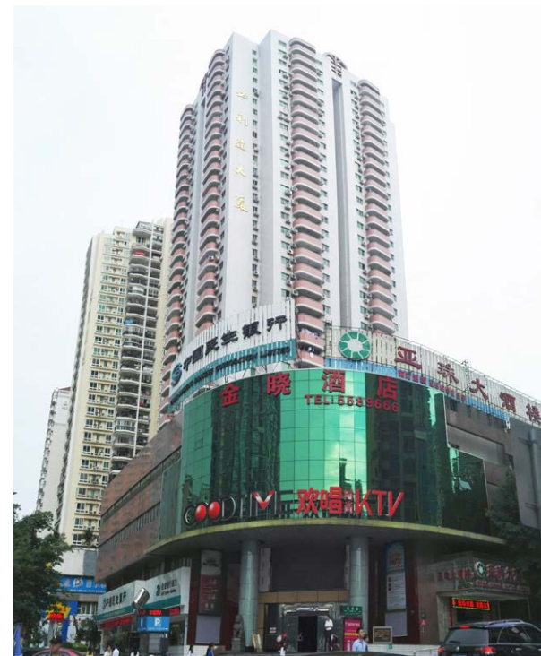
黄仲咸先生捐建的厦门必利达大厦（建筑面积4.5万平方米）
