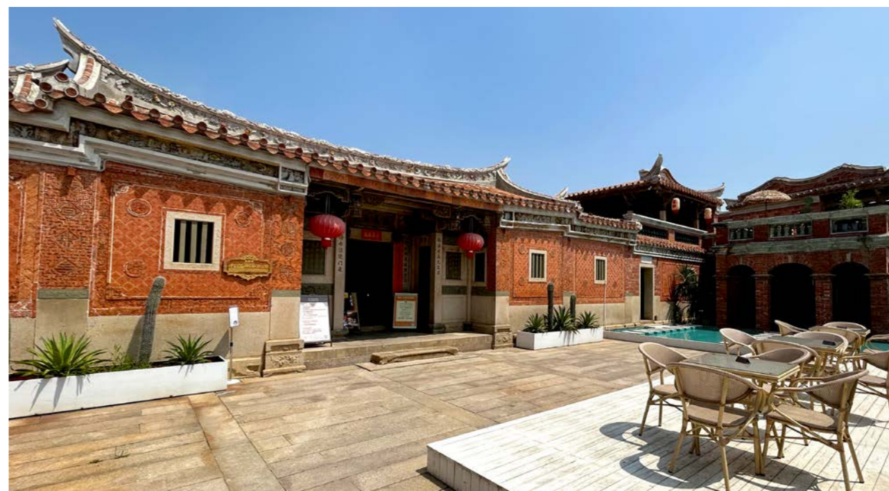
显辇宅 始建于1921年，坐西北面东南，为两落五开间闽南传统大厝，建筑面积714平方米，建筑墙裙采用四积撩砌筑法，屋顶为两面坡，三川燕尾脊硬山顶、马鞍形屋顶，使用木雕、石刻、泥空、剪瓷、整砖、砖雕、油漆、彩绘等多种装饰手法。建筑不仅规模大，装饰讲究，东护厝做法更是新颖、独特，是闽南传统建筑中的精品。
