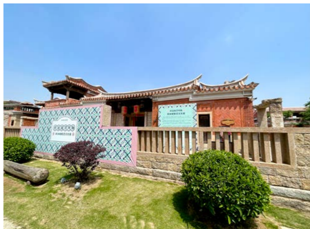
芳界宅 始建于1947年，坐西北面东南，为两落五开间闽南传统大厝，建筑面积500㎡。建筑墙裙采用传统的人字形砌筑法，屋顶为两面坡、三川燕尾脊硬山顶、马鞍形屋顶。建筑使用木雕、石雕、石刻、泥塑、油漆等工艺，阁楼众多且各带凉亭，别具特色。
