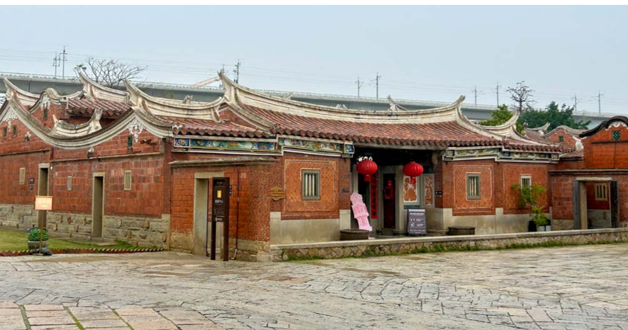
朝东宅 旅菲华侨蔡朝东宅邸，始建于清末，坐南朝北，为两落五开间的闽南传统大厝，建筑面积 342 平方米，三川脊屋顶。使用木雕、石雕、砖雕、灰塑、鑿砖拼砌、彩绘等装饰工艺，是闽南传统大厝中的典型代表。
