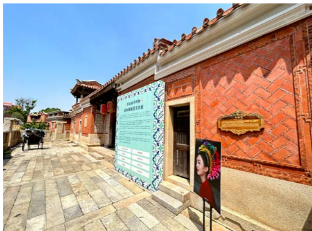
芳界宅 始建于1947年，坐西北面东南，为两落五开间闽南传统大厝，建筑面积500㎡。建筑墙裙采用传统的人字形砌筑法，屋顶为两面坡、三川燕尾脊硬山顶、马鞍形屋顶。建筑使用木雕、石雕、石刻、泥塑、油漆等工艺，阁楼众多且各带凉亭，别具特色。
