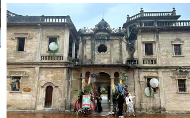
朝东楼 旅菲华侨蔡朝东宅邸，始建于 1930 年，坐东北面西南，为三层洋楼，建筑面积 928 平方米。辅楼顶楼有一平顶六角凉亭。门楼面西北，二层上有装饰蔓草纹的拜占庭式穹隆尖顶，该建筑未完成装修，但多处用水泥塑成的勋章、花卉、蔓草纹等装饰，充满异域风情。
