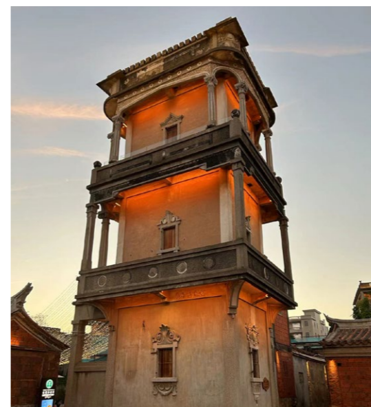
修养楼 俗称“枪楼”，建于 1934 年，坐东北面西南，三层碉楼。主体平面呈方形，建筑面积 131 m 2 。建筑四面围廊，二层起围廊四角立科林斯柱支撑，形成“四面八柱”构造。二、三层内壁间、廊道中开着里大外小的枪孔，便于朝不同方向射击。该建筑精巧的欧式建筑塑花工艺和借柱造廊技术，是梧林建筑群中西洋建筑工艺的代表作。
