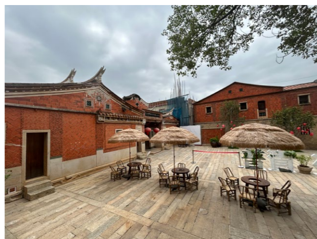
德越宅 旅菲华侨蔡德越宅邸，始建于 1928 年，坐西北面东南，为两落五开间的闽南传统大厝，建筑面积 318 平方米。主厝三川脊顶，阁楼与凉亭马鞍形屋顶。大门南向，有石刻楹联、线雕、浮雕、镂雕石构件和木雕装饰，墙面用拼砖装饰工艺。水车堵装饰灰塑花鸟、人物故事、彩绘图案，造型精美、色彩丰富。
