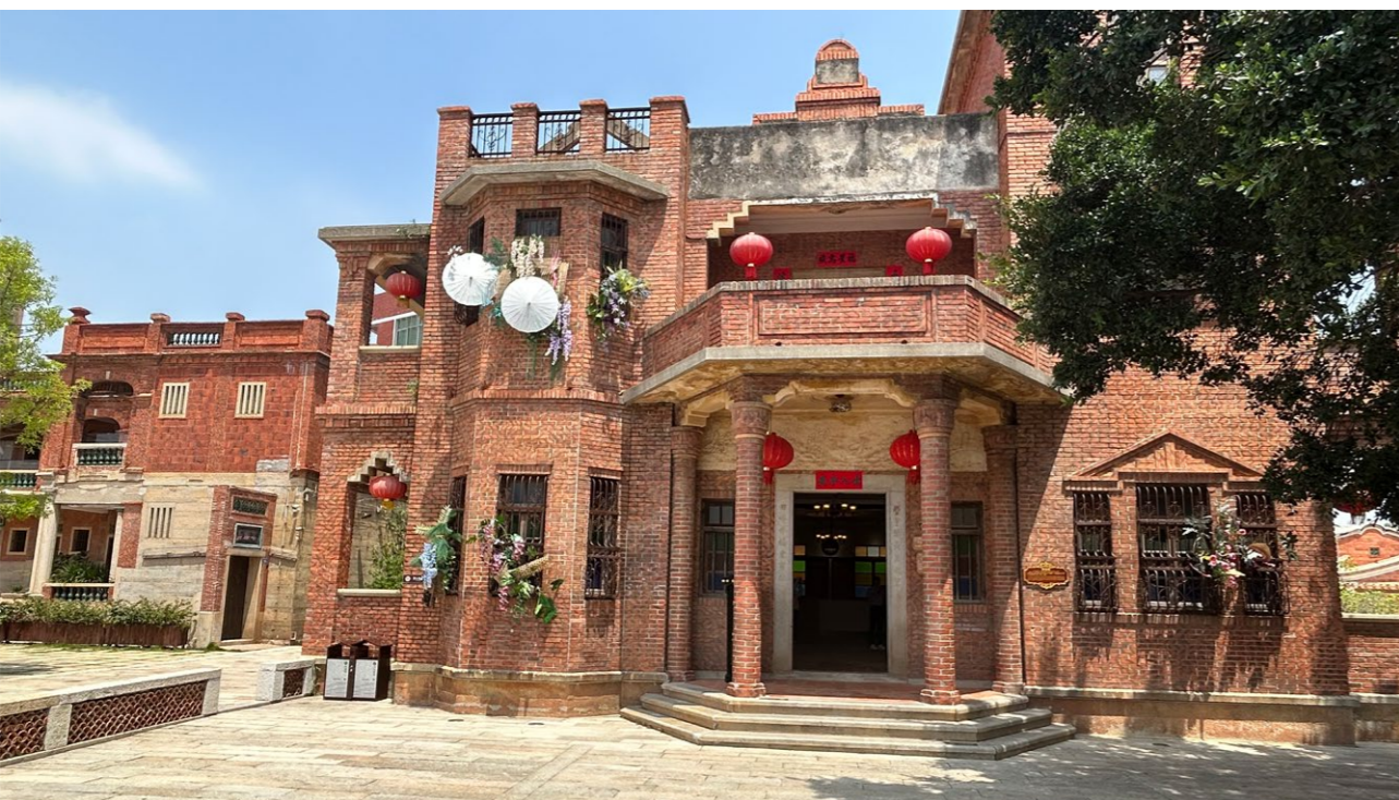
侨批馆 建于 1938 年，坐西北朝东南，三层红砖洋楼，由主楼和石埕组成，建筑面积 516 平方米。为方便家乡侨胞、侨眷，蔡顺意投资建设侨批馆，惜逢日寇入侵，未能完工，余下款项悉数捐予政府支援抗战。侨批馆转作梧林小学校舍，也被称为“旧学堂”。
