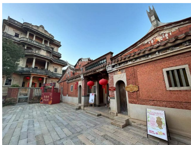
德越宅 旅菲华侨蔡德越宅邸，始建于 1928 年，坐西北面东南，为两落五开间的闽南传统大厝，建筑面积 318 平方米。主厝三川脊顶，阁楼与凉亭马鞍形屋顶。大门南向，有石刻楹联、线雕、浮雕、镂雕石构件和木雕装饰，墙面用拼砖装饰工艺。水车堵装饰灰塑花鸟、人物故事、彩绘图案，造型精美、色彩丰富。
