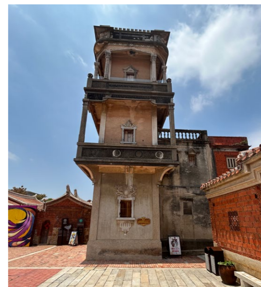
修养楼 俗称“枪楼”，建于 1934 年，坐东北面西南，三层碉楼。主体平面呈方形，建筑面积 131 m 2 。建筑四面围廊，二层起围廊四角立科林斯柱支撑，形成“四面八柱”构造。二、三层内壁间、廊道中开着里大外小的枪孔，便于朝不同方向射击。该建筑精巧的欧式建筑塑花工艺和借柱造廊技术，是梧林建筑群中西洋建筑工艺的代表作。
