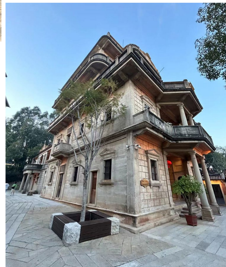
五层厝 旅菲华侨蔡德镛宅邸，建于 1936 年，坐西北朝东南，五层洋楼，建筑面积 735 m 2 。整体以钢筋水泥浇筑，二至五楼的围栏上留有多枪眼，用以防御。大楼主体完工后正值日本侵华战争爆发，为支援抗战，主人将装修款捐给政府用于购买抗战飞机。
