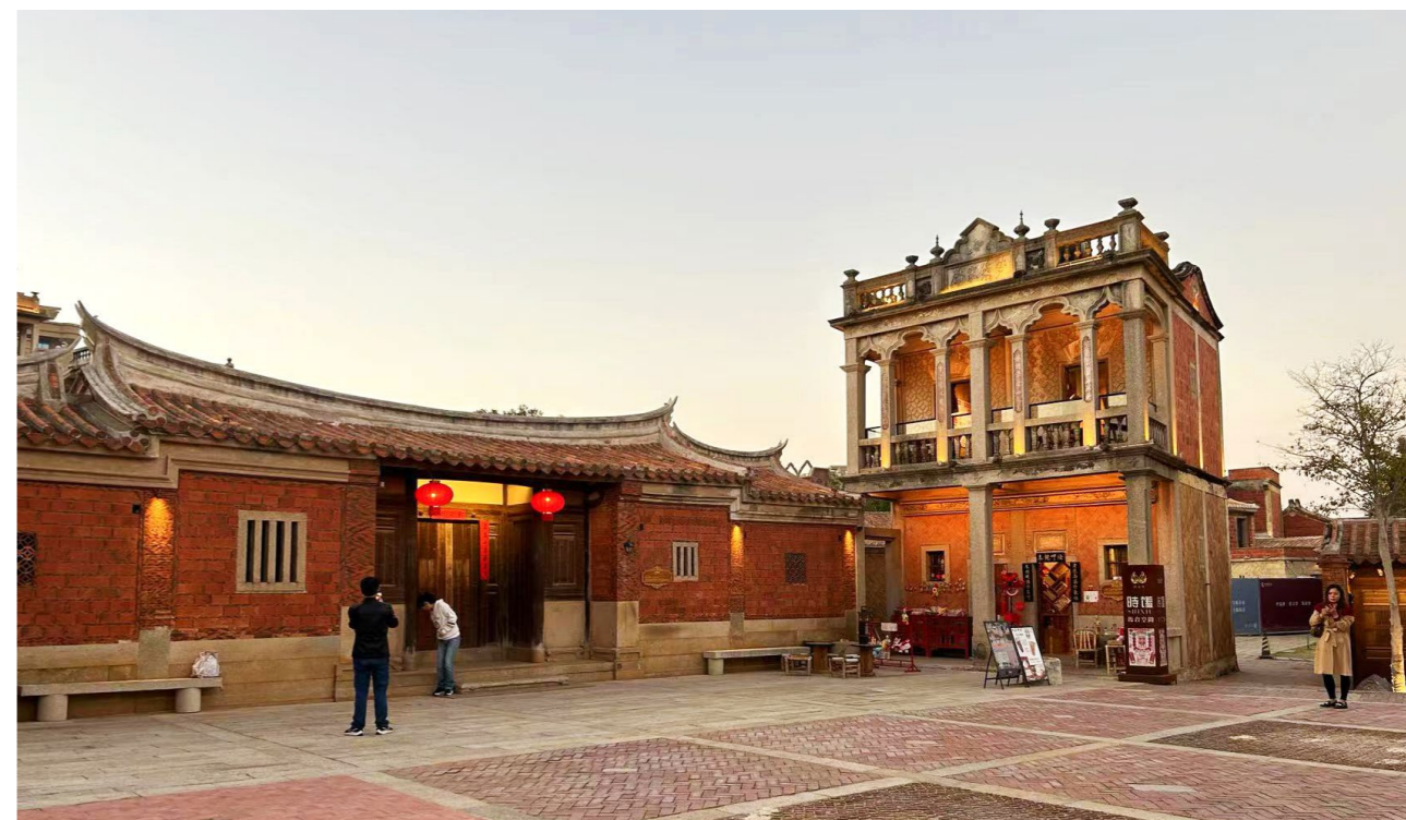
梦菜家声楼 建于 20 世纪 30 年代末，坐东北朝西南，为骑楼式的番仔楼，房间、走廊平面均呈平行四边形，建筑面积 90 m 2 。一楼墙体为白石人字形垒砌，二楼墙体用红色清水砖垒砌。二楼外廊为两组四柱三开间尖拱、圆拱的券柱廊。三楼正面筑造冠式山花。
