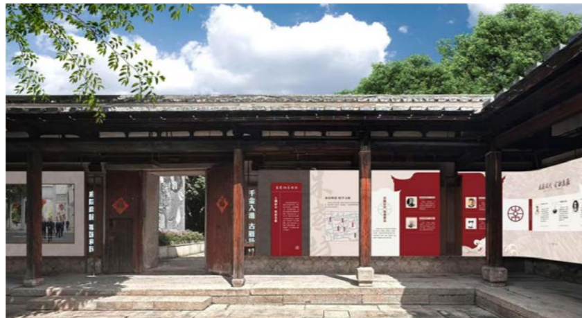
坐落于闽都古厝——朱紫坊历史文化街区内的朱紫坊基金港。图片来源：福州朱紫坊基金港
