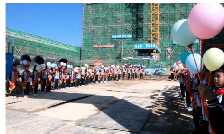
南金小学学生在新校址建设工地欢迎马来西亚华侨回乡参观
